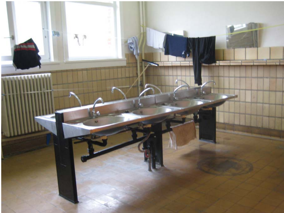
Een geïmproviseerde wasdraad in de sanitaire ruimte (Lombardsijde 27 augustus 2008)
